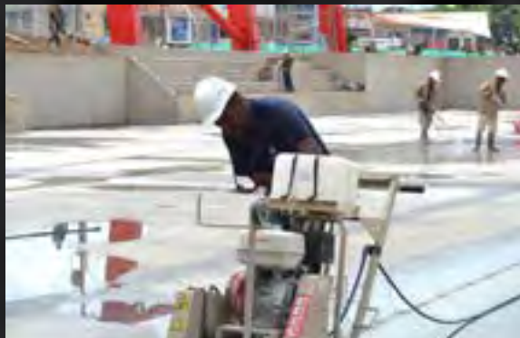
Corte de juntas en CONCRETO / ASFALTO
