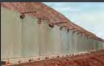
Cimentaciones & Muros de Contención
